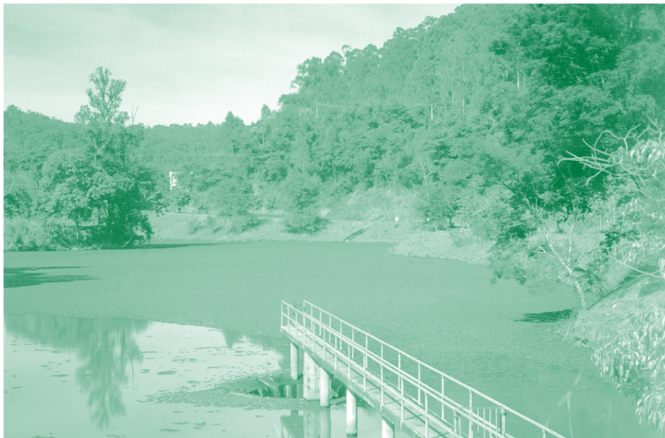
Figura 5. Torre de tomada de água (observar os sinais nítidos de eutrofização: proliferação de salvínea)
