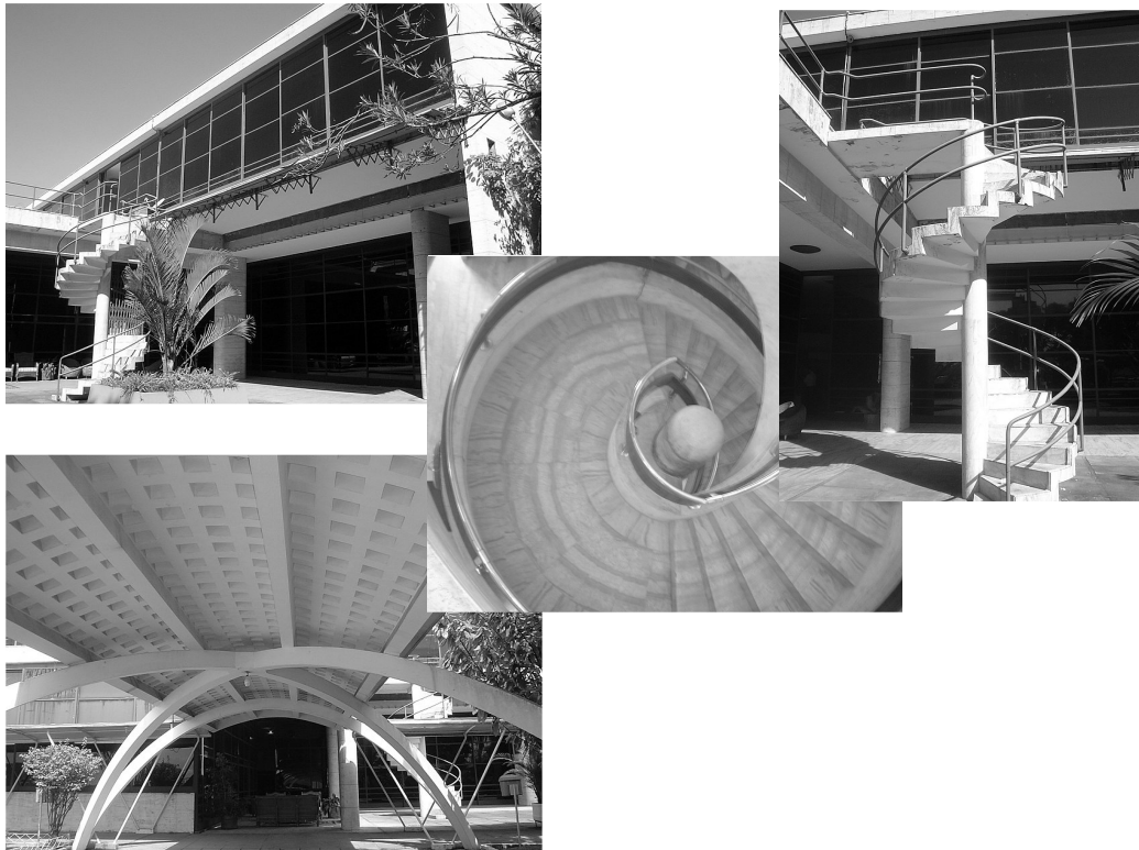
Figura 20 - Estação de Hidroaviões do Aeroporto Santos Dumont, atualmente sede do INCAER. Fonte: Fotos da autora - 2005
