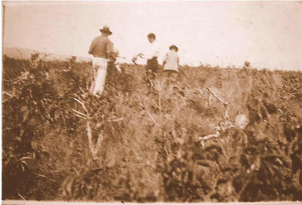
Figura 111 – Attilio Corrêa Lima na locação da cidade. Fonte: Acervo Corrêa Lima – Plano Diretor de Goiânia
