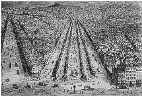
Figura 46 – Avenidas monumentais de Haussmann para Paris e a regularidade dos gabaritos dos edifícios.
