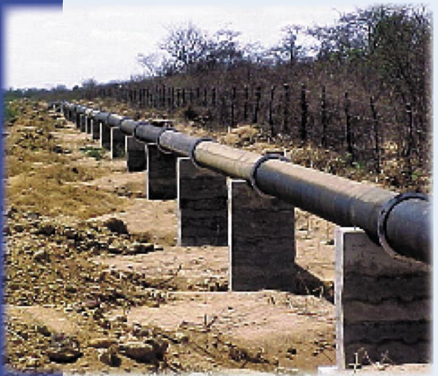
Adutora - Serra de Santana - RN
