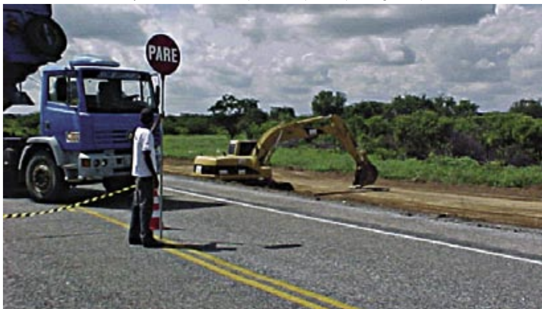
Travessia Sob Rodovia - Adutora Afrânio Dormentes - PE
