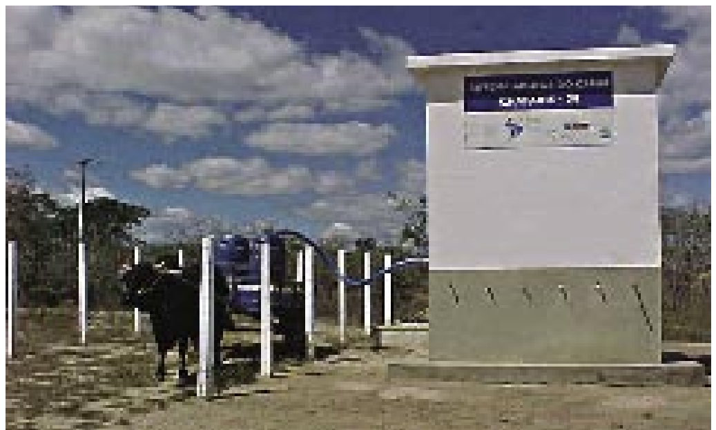
Chafariz - Sistema Adutor Cariri - PB
