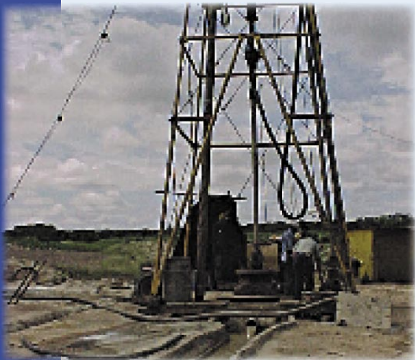
Perfuração de Poço - Sistema Adutor Afogados Ingazeira - PE
