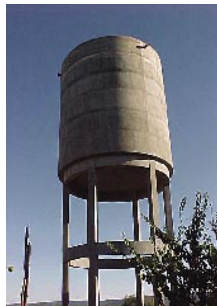
Reservatório Elevado - Padrão Central - BA
