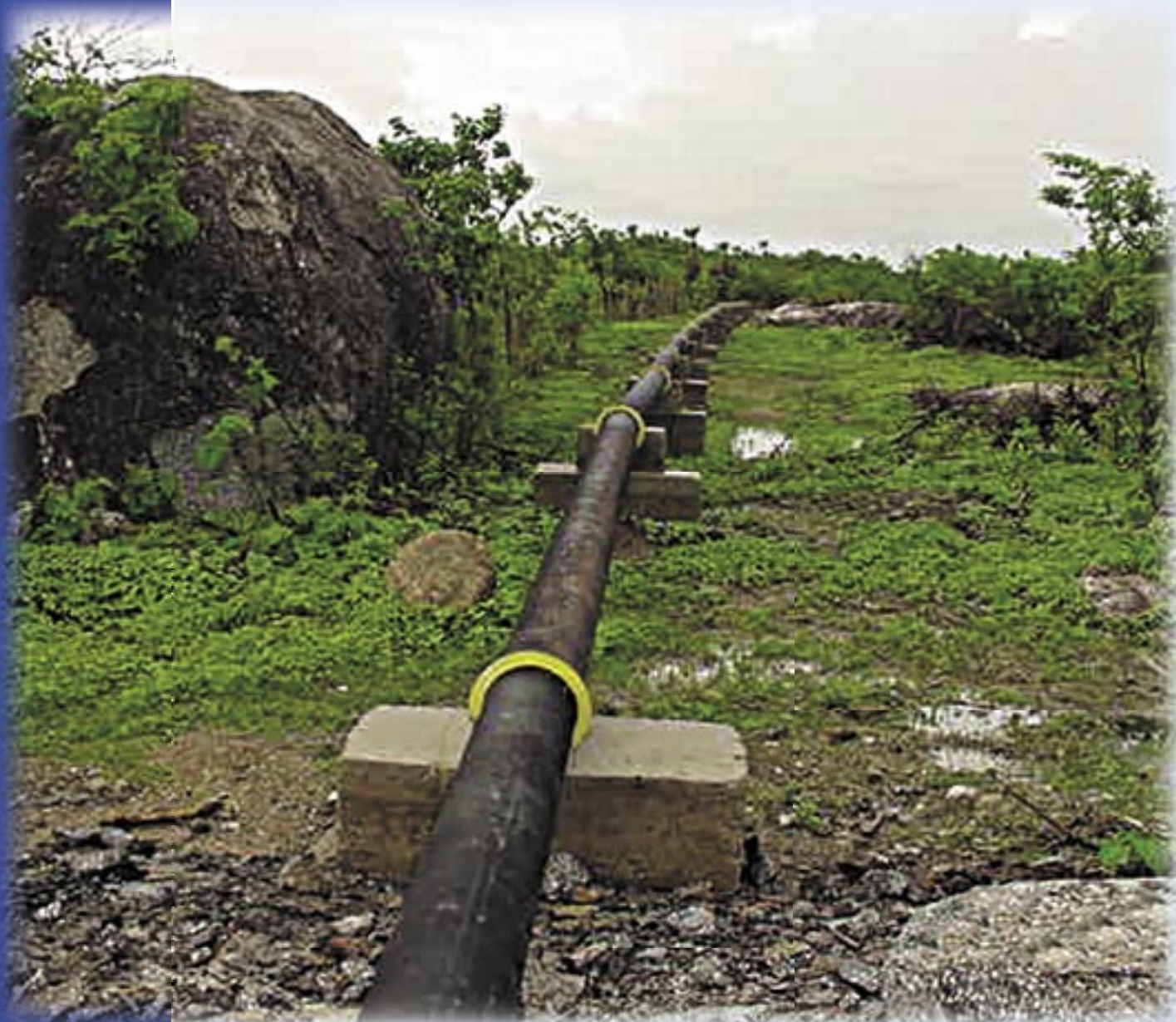
Adutora do Chaval Barroquinha - CE
