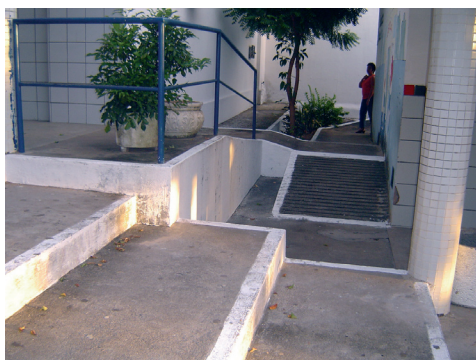
Foto 2: Rampas de acesso
