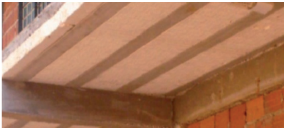
Laje com enchimento de isopor.
