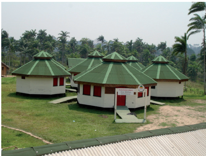
Efeito chaminé para ventilação em escola indígena Yawanawá. Desenho com o efeito chaminé. (Fonte: FNDE/MEC, 2002.)
