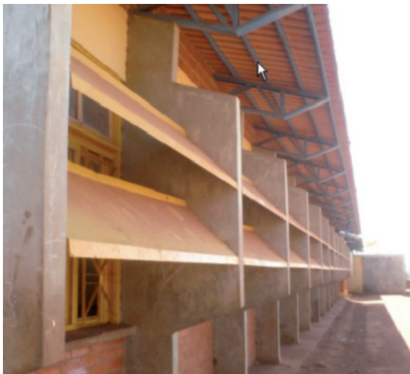
Uso de quebra-sol em escola. O telhado também auxilia na proteção à insolação.
