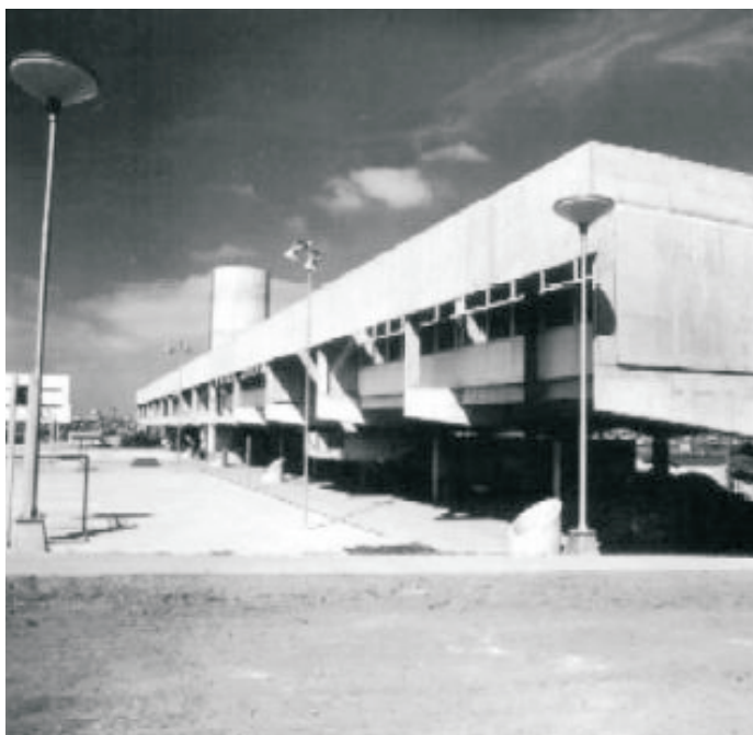
Quebra-sol de concreto.
