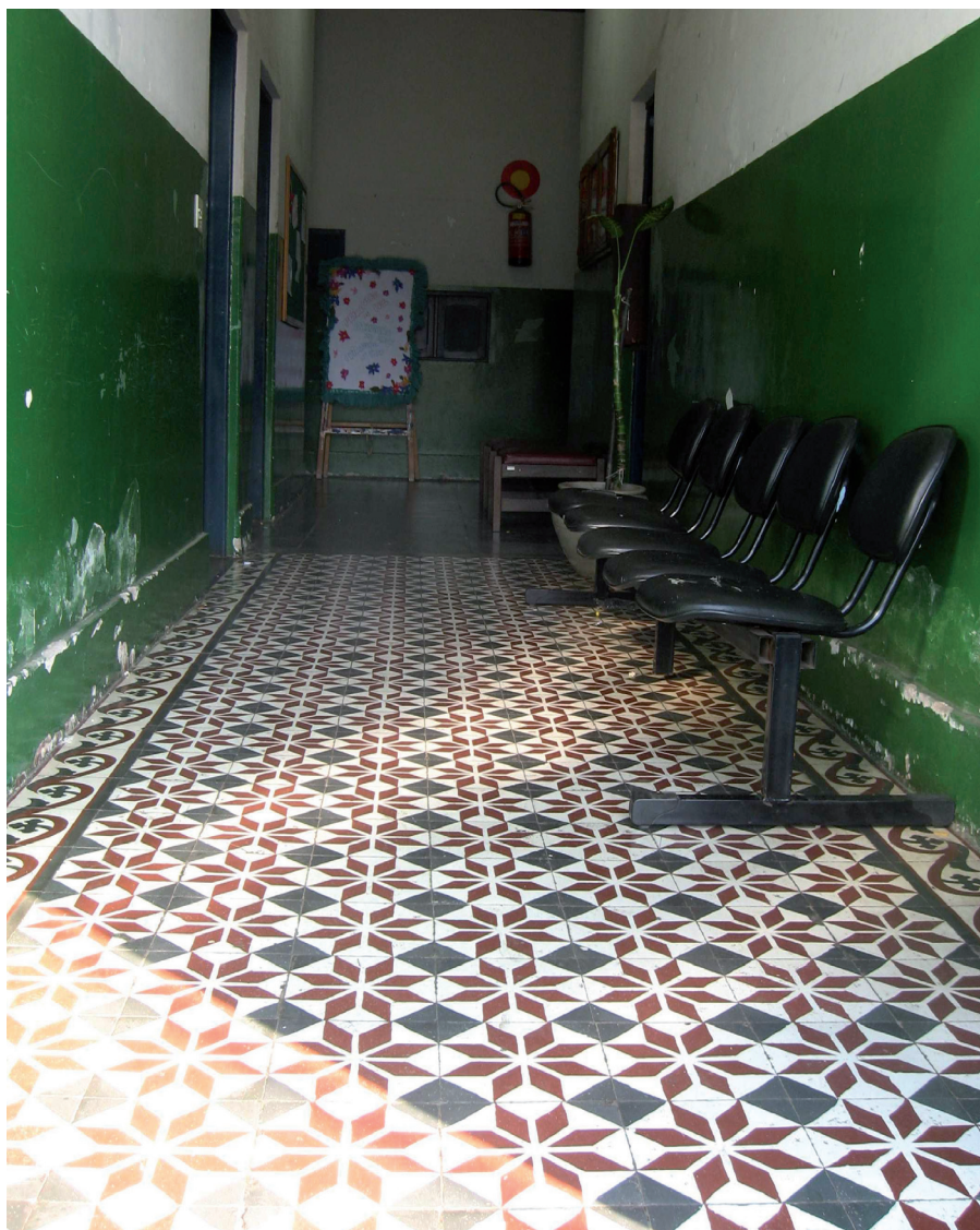
Piso de ladrilho hidráulico em escola na cidade de Ouro Preto-MG
