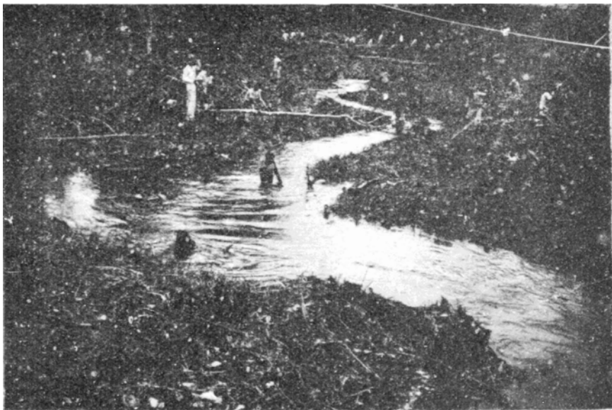
SANEAMENTO E COLONIZAÇÃO DE CAMARATUBA — Turmas de operários, em trabalho de desobstrução, no riacho do Valentim
