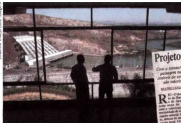
Hidrelétrica de Furnas
