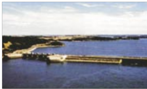
FIGURA 2.20 – ESTAÇÃO DE ENERGIA DE MARÉS NO RIO RANCE, FRANÇA
