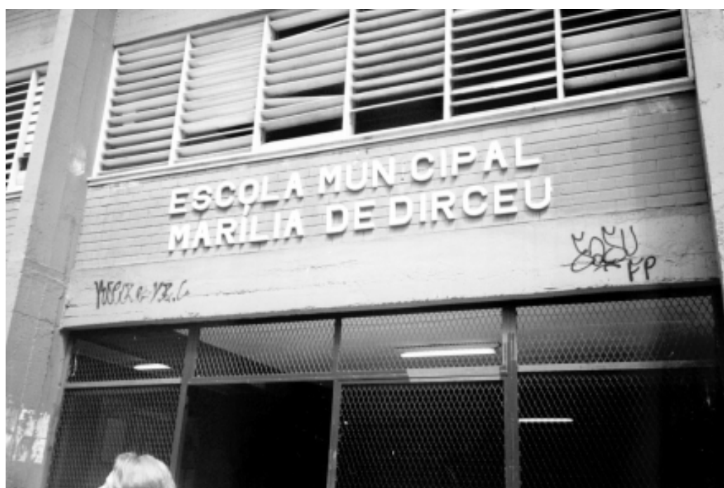
Figura 8 – Fachada da Escola Marília de Dirceu
