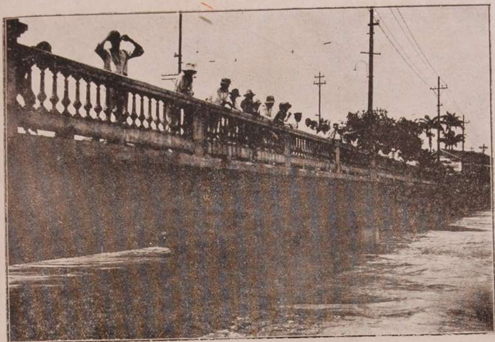
Ponte da Torre por ocasião da ultima cheia
