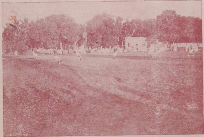
TORRE x FLAMENGO
