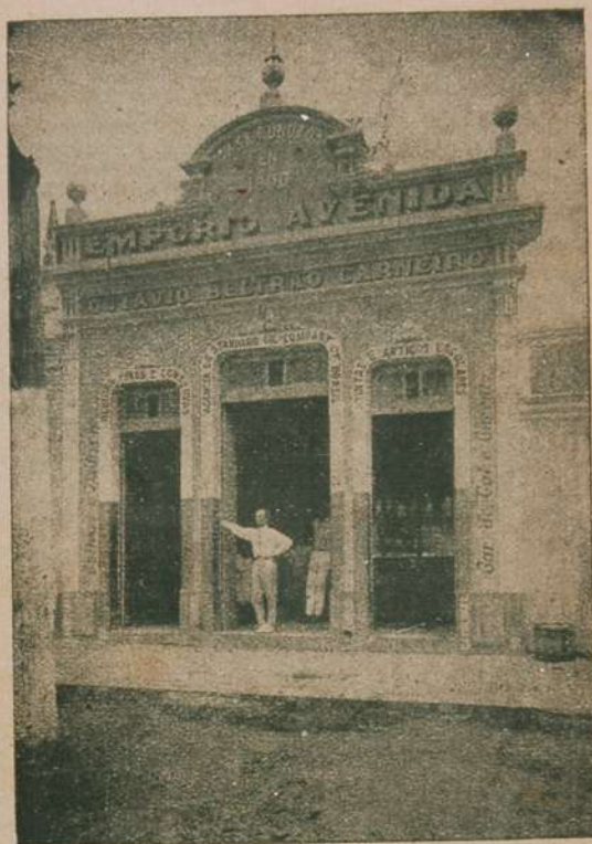
Fachada do prédio onde se encontra estabelecido o sr. Octavio Beltrão, na aprazível villa "Floresta dos Leões".
