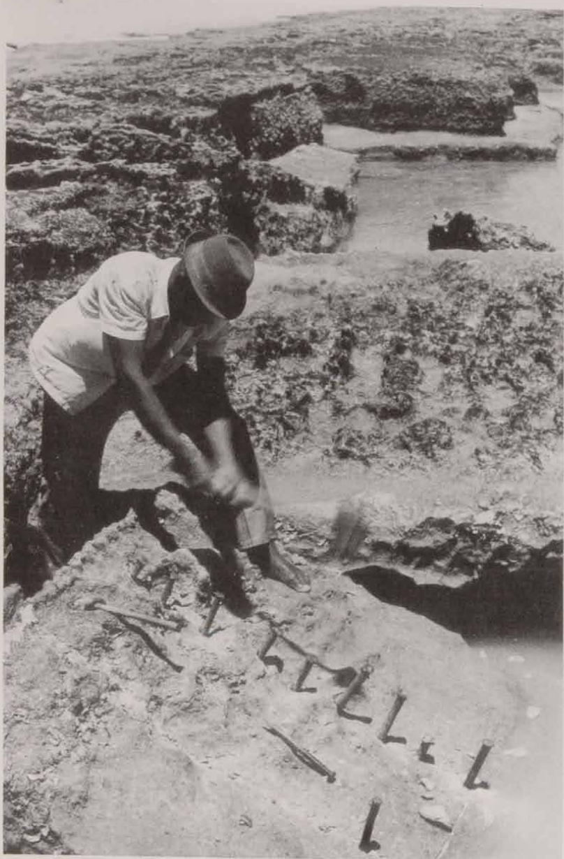
Foto 102 — Retirada de arenito dos arrecifes na praia de Gaibu. Note-se a técnica empregada para o corte dos blocos retangulares. Foto de 1978.
