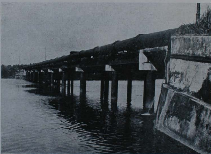
A velha Ponte dos Carvalhos, sobre o rio Jaboatão, na estrada de rodagem do Recife ao Cabo e a Gurjahú. Dá passagem á linha adductora dos mananciaes, que abastecem a cidade.
