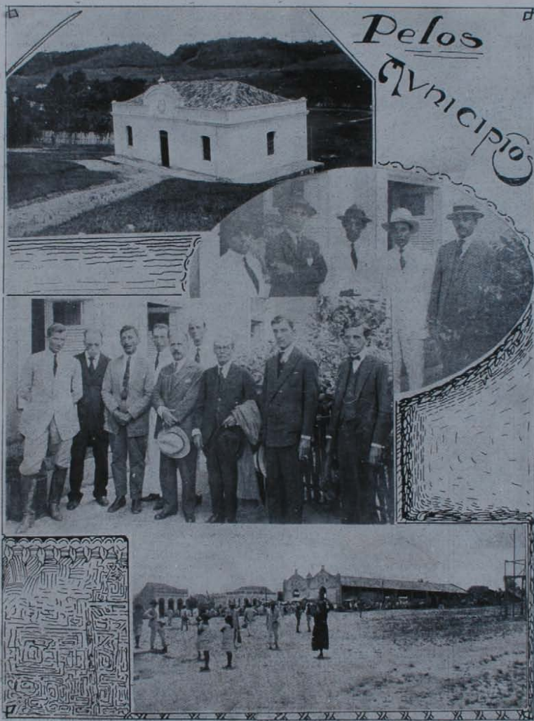
1) Edifício da Cadeia Pública, 2) Semadôres Epanimômbis de Barros e Davino Pontual, 3) Dr. Ernesto Santos, Juiz de Direito e Concelheiros municipais, 4) Praça do Mercado.
