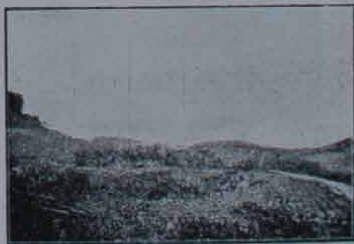
Um trecho da Estrada entre Colonia e Passo do Camaragibo
