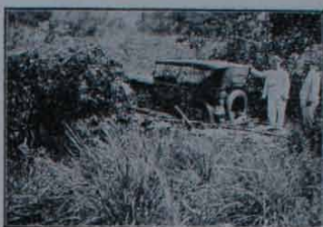
Ponte quebrada na passagem de um carro. Engenho Botija. — Estado de Alagoas
