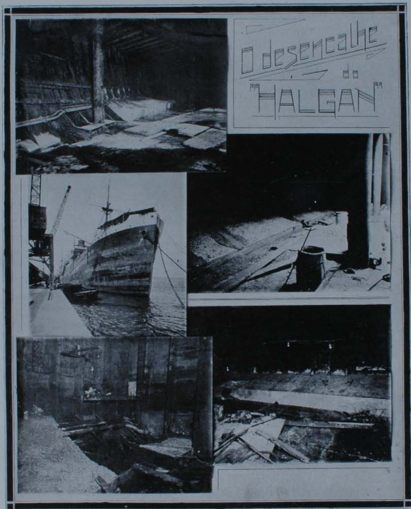
No centro a esquerda vê-se o paquete "Halgan" atracado as Docas do Porto após o seu desencalhe. As outras photographias representam o interior dos porões do grande cargueiro francez, mostrando o grande trabalho em concreto, realizado com o navio flutuando.
