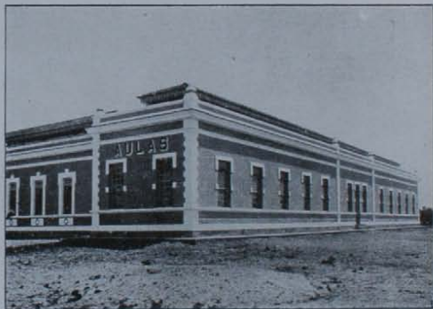
Edifício destinado ás aulas
