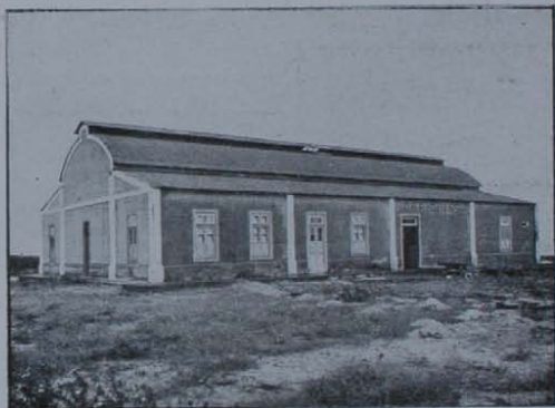
Edifício das officinas
