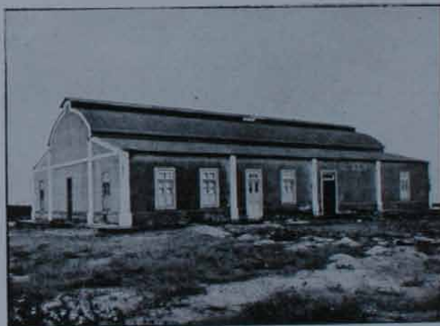
Edifício das officinas
