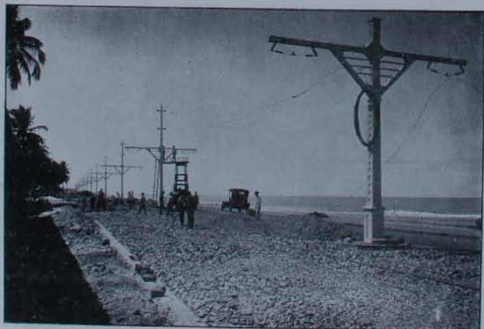
O serviço do assentamento do cabo aereo para o prolongamento da linha dos bondes da "Pernambuco Tramways"
