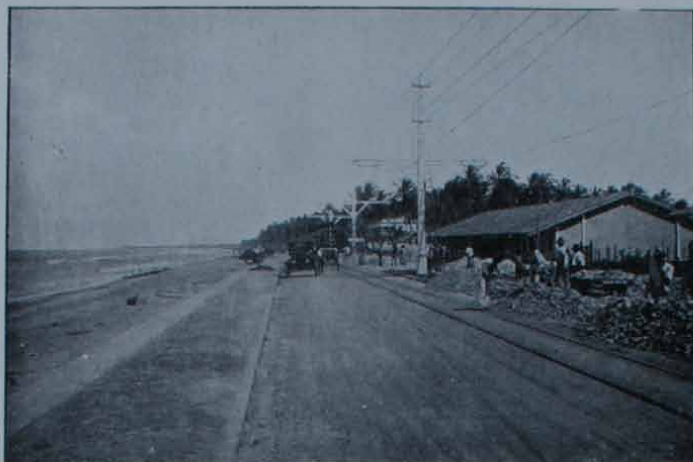
UM BELLO FLAGRANTE DA NOVA FAIXA ASPHALTADA
