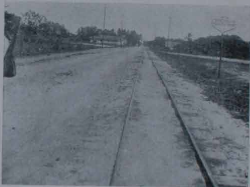
Outro aspecto da mesma Estrada. A linha ferrea que se vê á direita é a da conservação da linha de carros aductores que abastecem d'agua o Recife.
