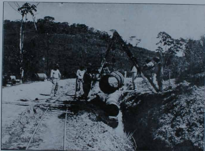
Os serviços de assentamento da segunda linha adductora de Gurjahú a Prazeres na estrada de Recife ao Cabo.
