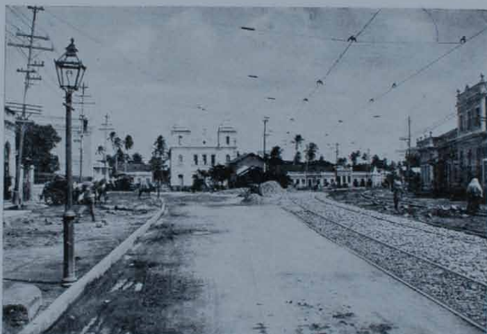
Proseguem as obras do calçamento a asphalto do Largo da Paz, no bairro de Afogados. Na photographura pode-se apreciar o estado actual das obras com que a Prefeitura está embelezando aquelle pittoresco recanto da cidade.
