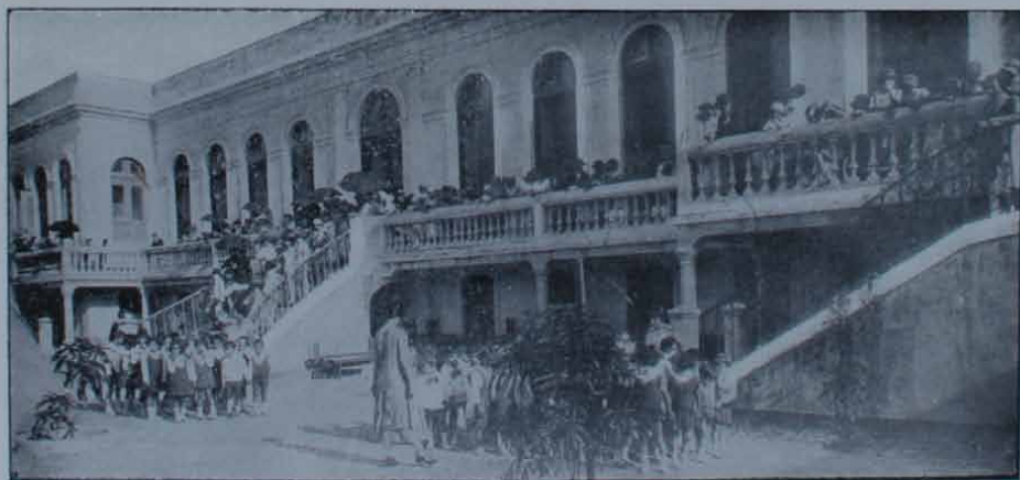
Aspecto da parte posterior do edificio por occasião da festa.
