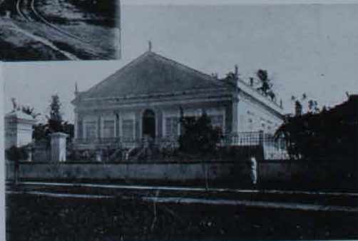
4 — Edifício onde deve funcionar o Hospital Regional, doado ao município pelo deputado Arthur Lundgren.
