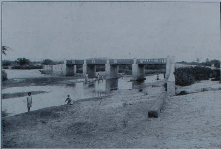
PONTE SOBRE O RIO IPOJUCA — no povoado de Antonio Olyntho, do municipio de Caruaru, ultimamente reconstruida sob a direcção do Departamento de Viação e Obras Publicas.
