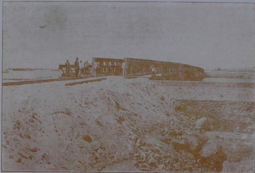
Aterro junto à ponte gyratória
