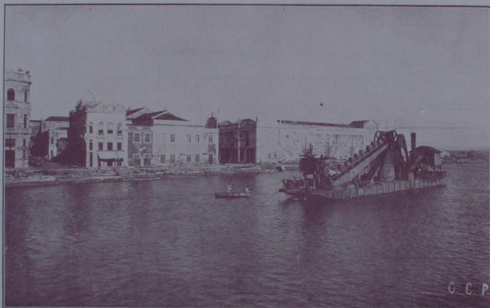
Outro aspecto do serviço de dragagem para o caes de 4m.50
