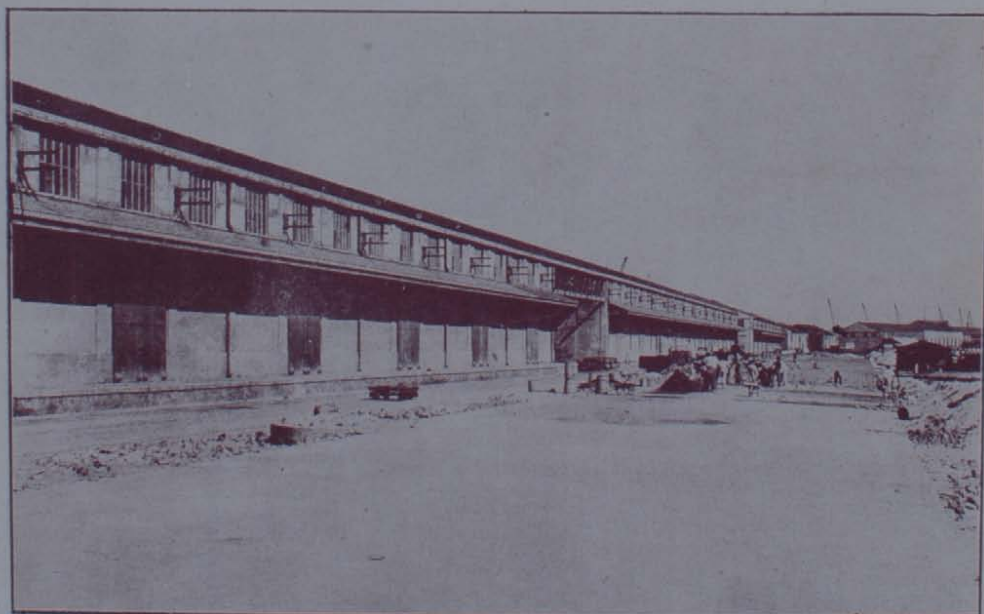
Os trabalhos da construção do calçamento da Avenida do Porto, em plena actividade
