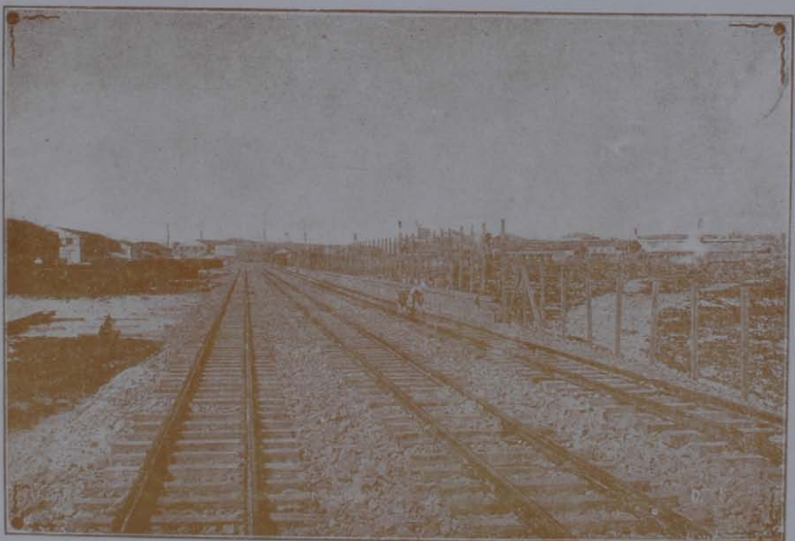
Novas linhas ferreas em construção
