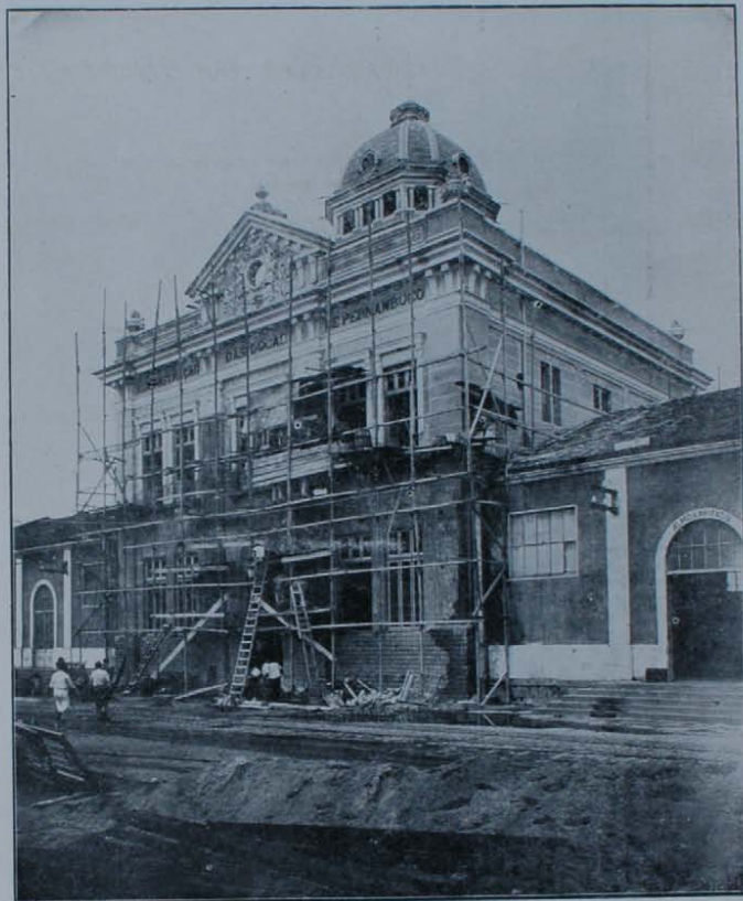
O Estado das obras de construção do edificio das Docas do Porto
