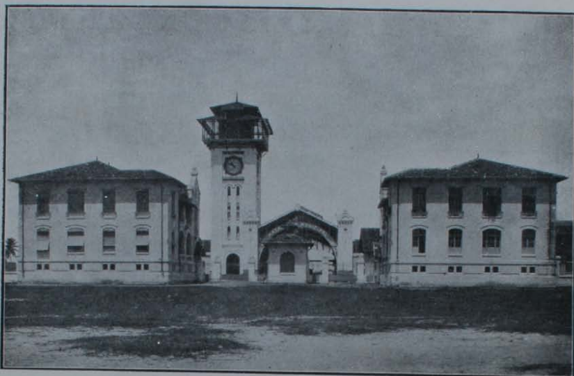
Vista da entrada principal do Matadouro Modelo, nos Peixinhos.
