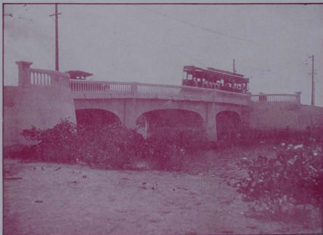
Ponte de Tacaruna, em cimento armado construída na actual administração
