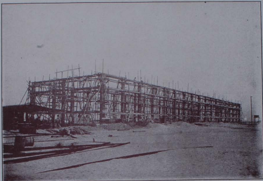
Os armazens de inflammaveis, em construção
