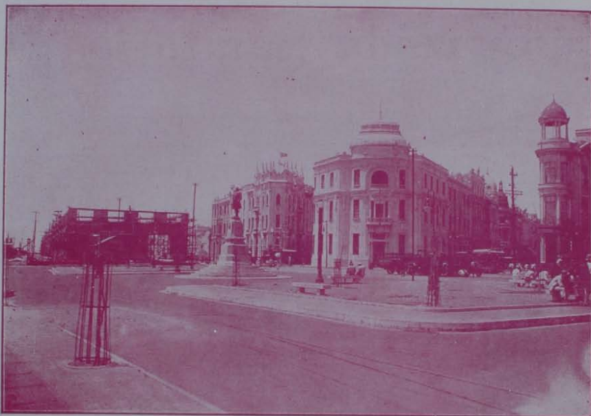
A Praça Rio Branco, vendo-se as obras do armazem n. 9, hoje quasi concluidas
