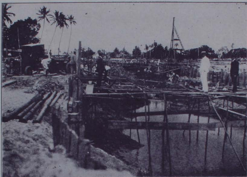
Preparo da cava para a construção, em concreto, do radier, da futura ponte que, sobre o Canal do Derby, unirá os dois trechos da "Avenida 18 de Outubro"
