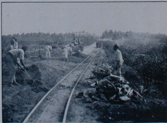
Serviço de macadaminação da estrada de rodagem do Recife ao Cabo.
