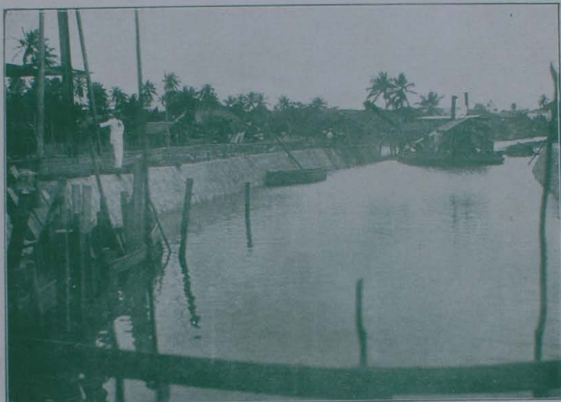
Trecho de caes, já concluído, no futuro canal do Derby
