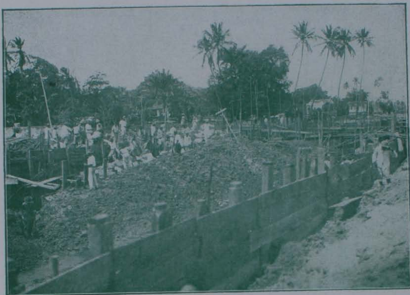
Construção de um dos caes marginaes do futuro canal do Derby
