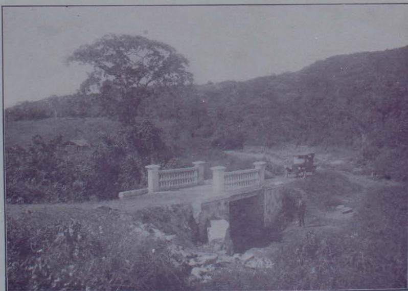
Pontilhão de Recreio. — Estrada de Nazareth a Timbaúba
