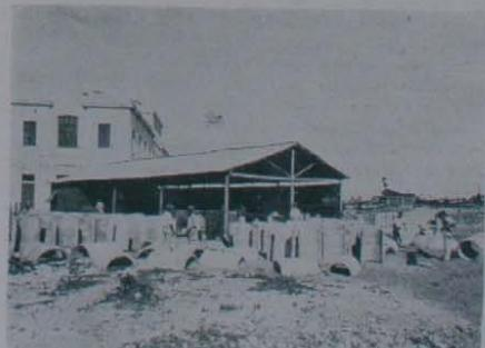
Estaleiro para a confecção de tubos para as galerias de águas pluviais.
