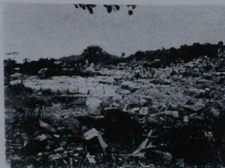
COMPORTAS: — Vista parcial da pedreira C. confecção de coberturas para o caes meios fios, parallepipedos.
