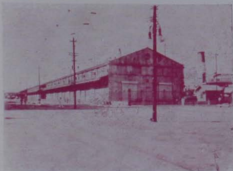
O seu novo aspecto depois de retirado o gradil ali existente. Vista do armazem 8.
