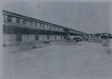
Um trecho do novo calçamento em frente aos armazens 1 e 2.
