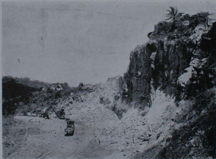
OBRAS DO PORTO DO RECIFE. — Pedreiras de Comportas.
