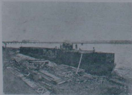
Reparo de um batelão porta-blocos, em Santo Amaro
