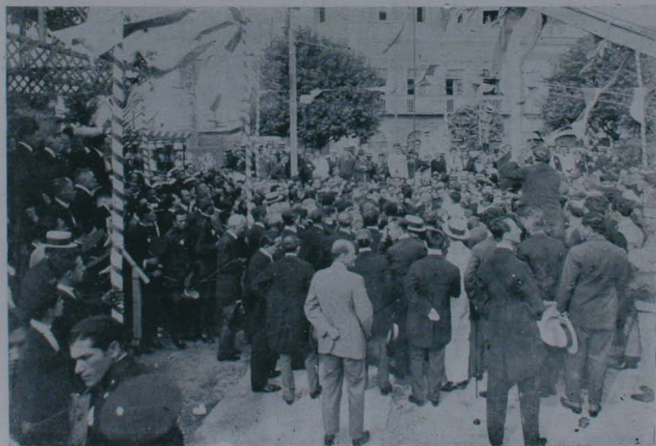
PALACIO DA JUSTIÇA DE PERNAMBUCO — A solemnidade do lançamento da pedra fundamental, vendo-se o exmo. sr. governador ladeado de altos representantes dos poderes publicos
