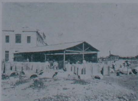
Estaleiro para a confecção de tubos para as galerias de águas pluviais.
