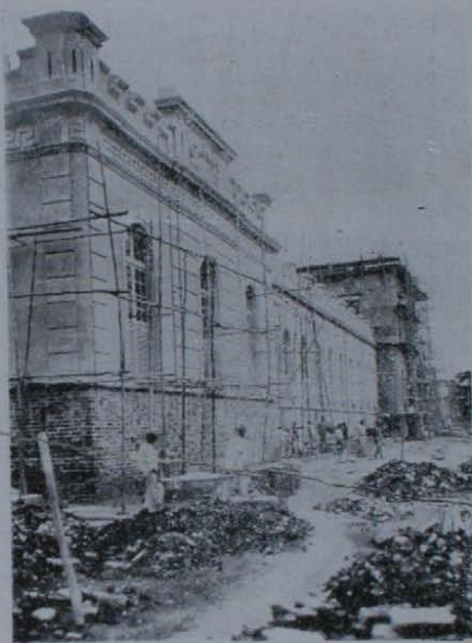
O NOVO QUARTEL DO DERBY — Vê-se o estado das obras; a parte central do edificio, quasi concluida.
