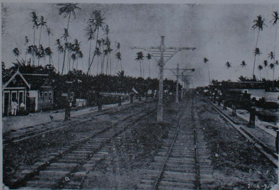
A AVENIDA LIGAÇÃO, que une a ponte da Pena ao inicio da avenida Beira-Mar. Ao centro, os postes de cimento armado, indicados pelos trilhões da futura linha de bondes. Aos lados, os passeios arborizados.
