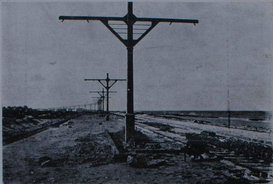
A AVENIDA BEIRA-MAR. — Estado das obras, vendo-se os elegantes postes de cimento armado, os meios fios, as linhas d'agua promptas e a macadamização iniciada. Ao centro, as Linhas da Pernambuco Tramways
