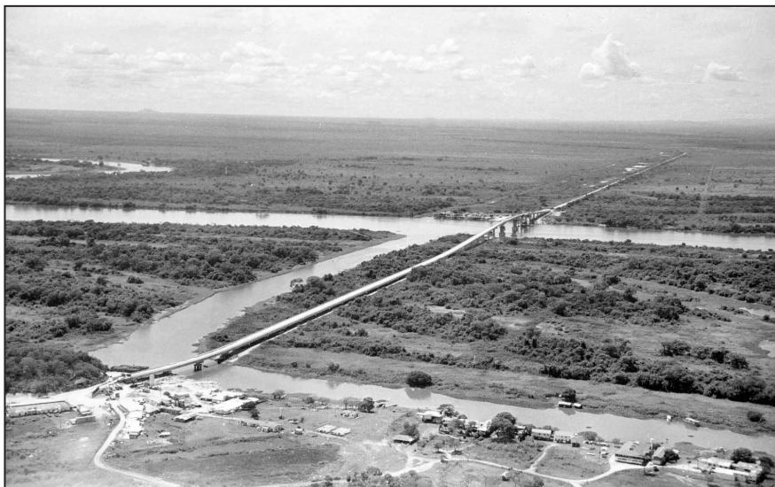
Visão geral da ponte sobre o rio Paraguai. Foto: www.apn.ms.gov.br
