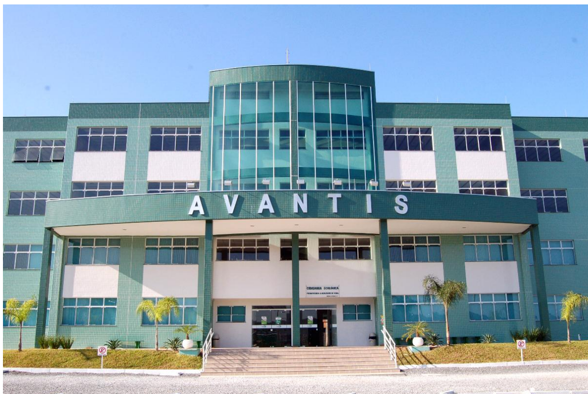
Fotografia 1 – Instalações atuais da Faculdade Avantis Fonte: Arquivo da Instituição, 2009
