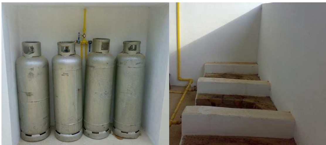
Foto 9. Fornalha a gás com queimadores industriais. Direito de imagem cedido pela SEUDV. Foto: Wagner Lira.
