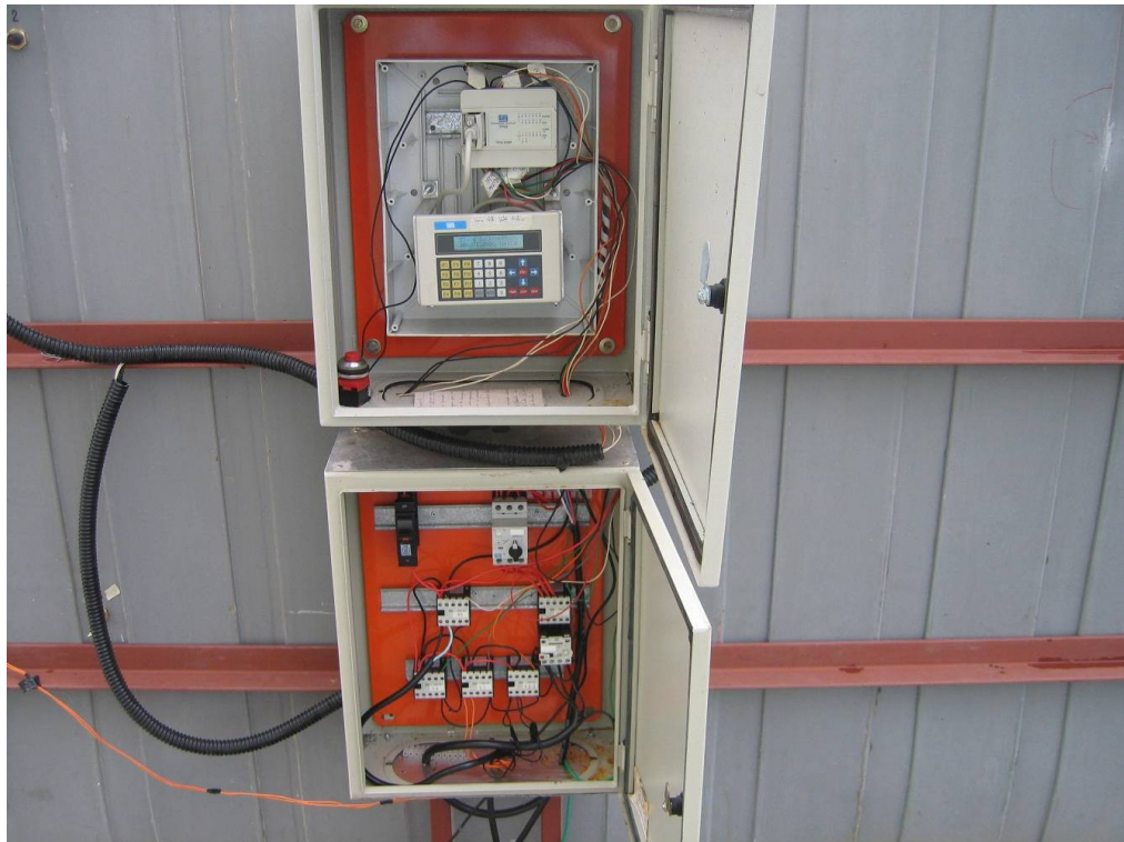
Figura 7: Comando eletrônico utilizado no RSB Fonte: Rodriguez (2007).
