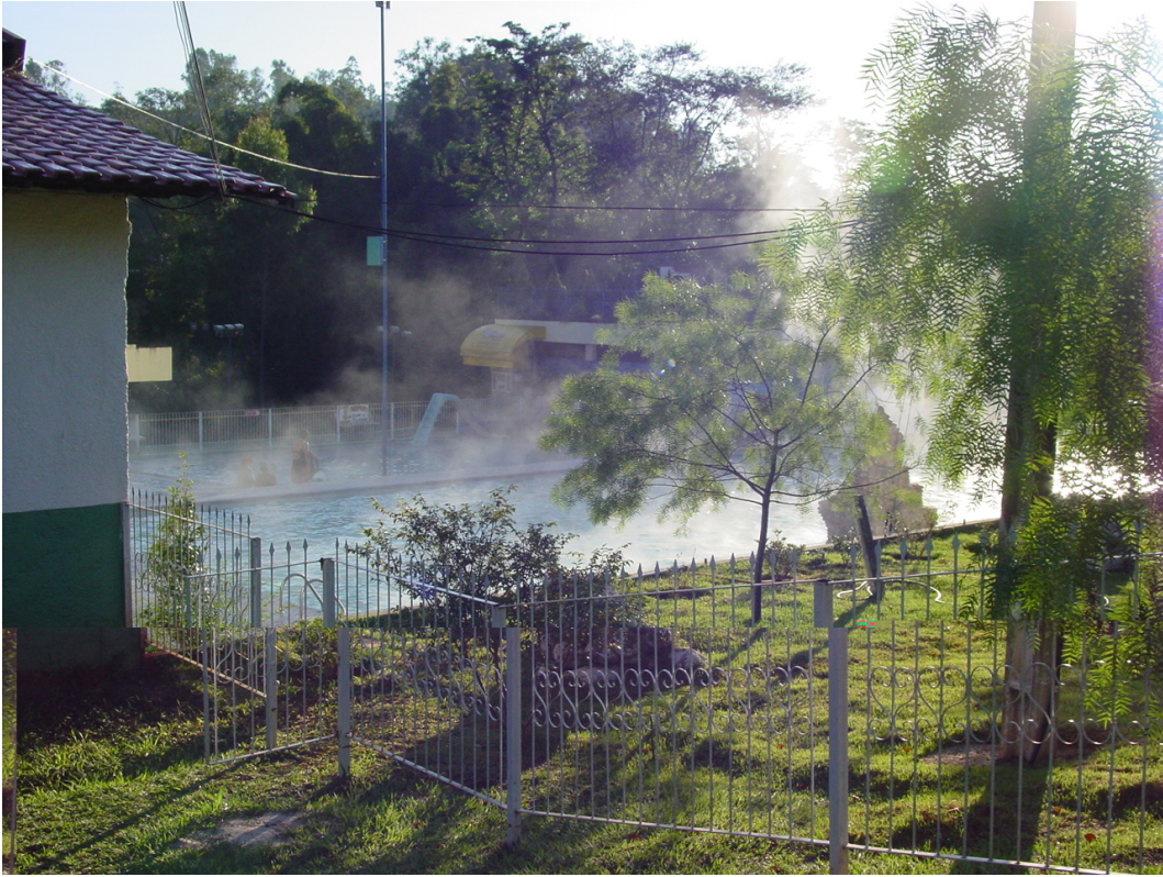
Figura 48 – Piscina do balneário Termas de Londrina abastecida com águas termais do SAG (Londrina, PR)
