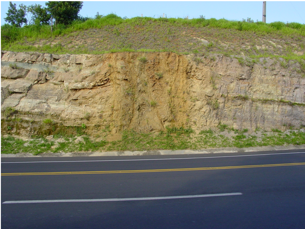
Figura 13 – Dique intrudido em siltito da Formação Rio do Rasto (BR 376 – Serra do Cadeado)
