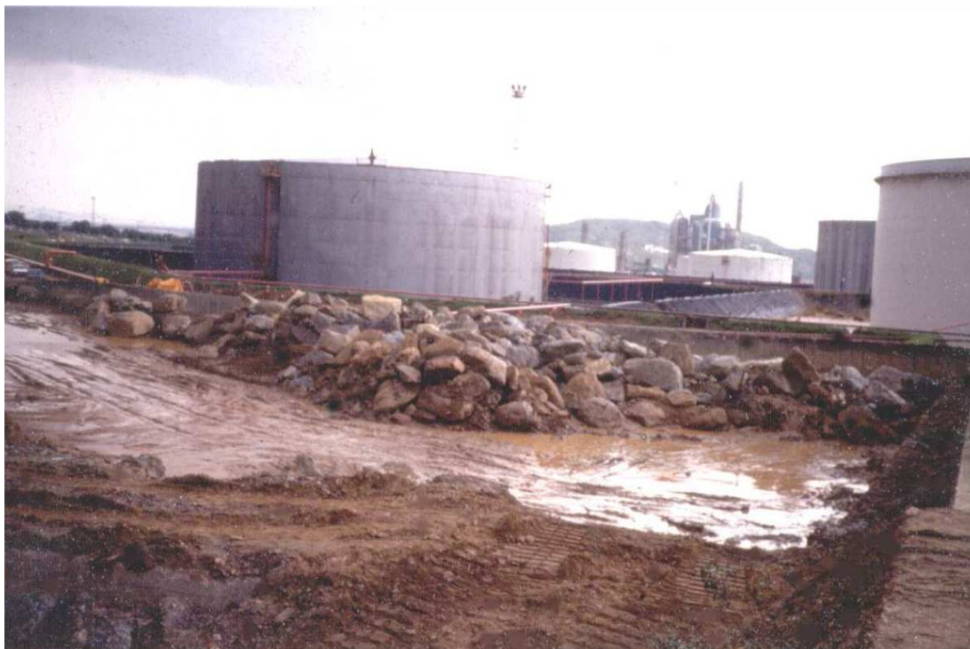
Figura 3.11 - Deposição de blocos de rocha de grandes volumes e lama na área da planta industrial de Cubatão (1994).
