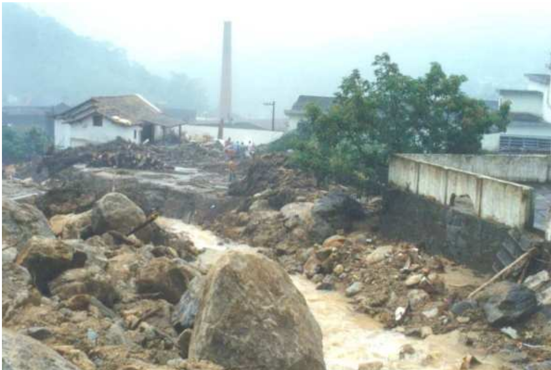
Figura 3.8 - Grandes volumes de blocos de rocha no fluxo de detritos de Petrópolis em 1988.
