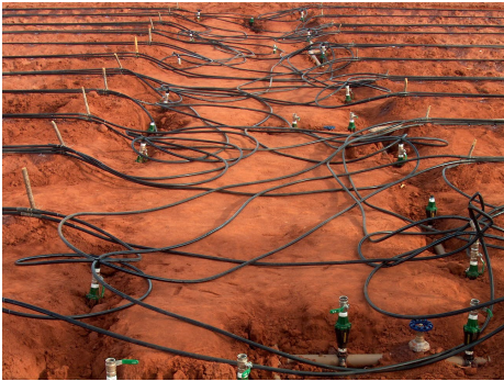
Figura 2. Instalação do sistema de irrigação.
