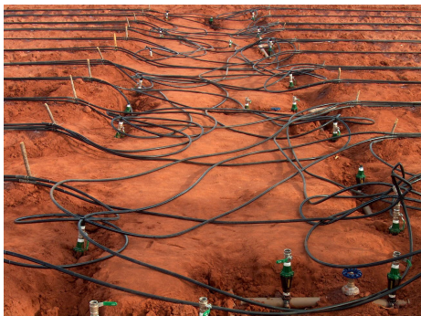
Figura 2. Instalação do sistema de irrigação.
