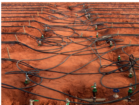
Figura 2. Instalação do sistema de irrigação.
