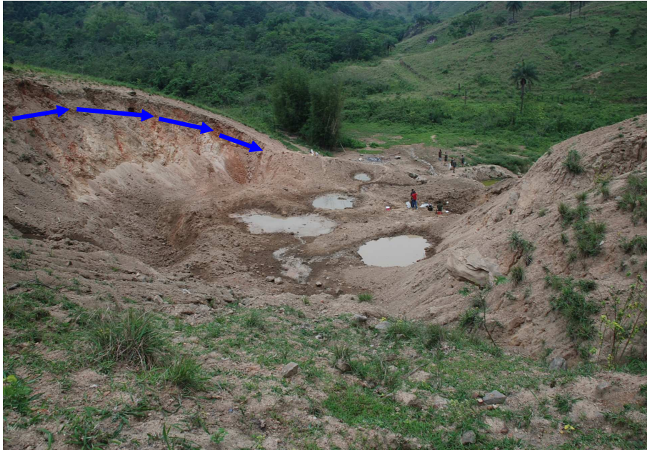
Figura 4.29: Afloramento do NA no centro da área de destruição.
