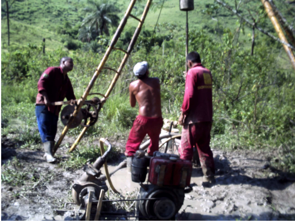
Figura 4.22: Execução do furo SP06-sondagem à percussão.
