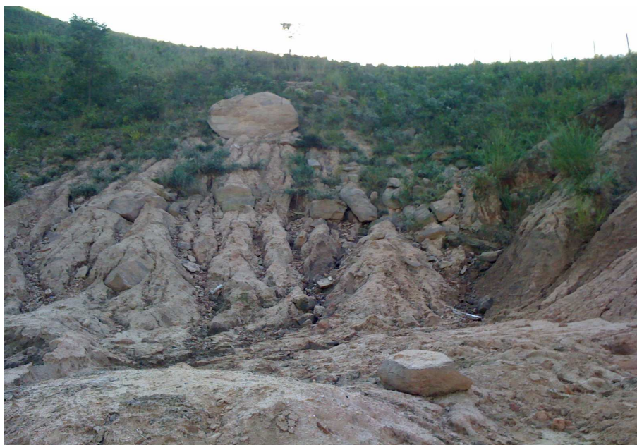
Figura 4.28: Vista frontal da área de destruição após a ocorrência de fortes chuvas
