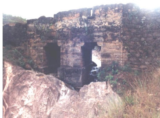
Figura 14: Ponte do Calixto
