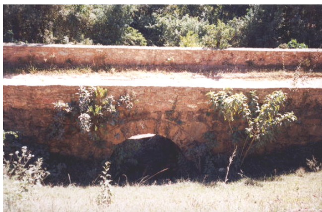
Figura 13: Ponte sobre o córrego Água Espreada:
