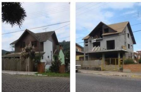
Figura 8: Edificações novas nas áreas protegidas e não protegidas pelo IPHAN em Antônio Prado. Mapa e fotos: acervo Escritório Técnico II – Antônio Prado / IPHAN-RS
