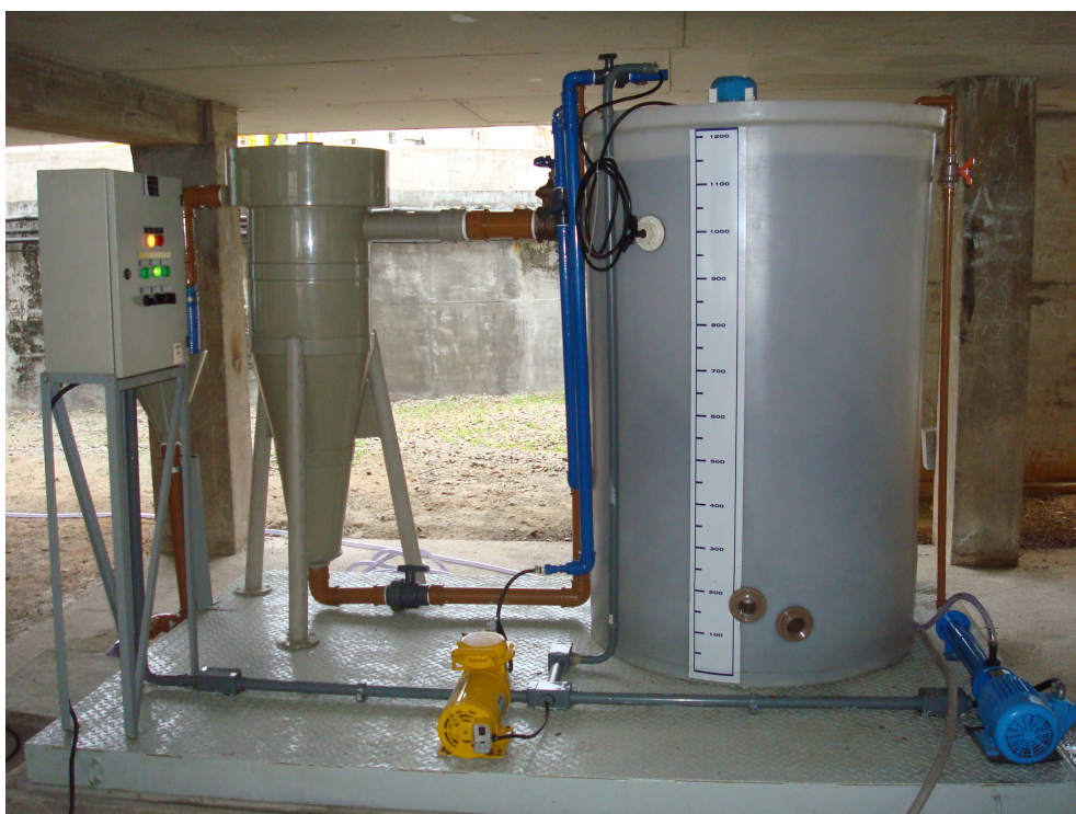
Figura 6 - Estação de tratamento por lodos ativados em escala piloto.
