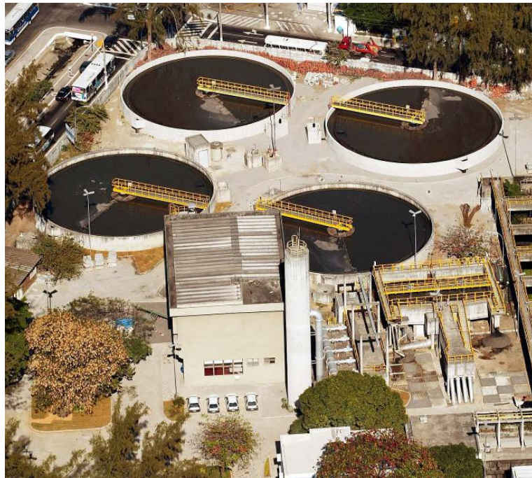
Figura 2 - Vista aérea da ETE Icaraí.
