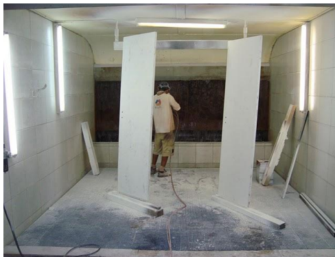
Figura 5.13 – Aplicação do fundo preparador Fonte: Autor
