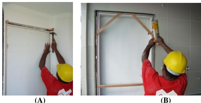
Figura 5.23 – A: Fixação provisória. B: Fixação permanente. Fonte: Autor
