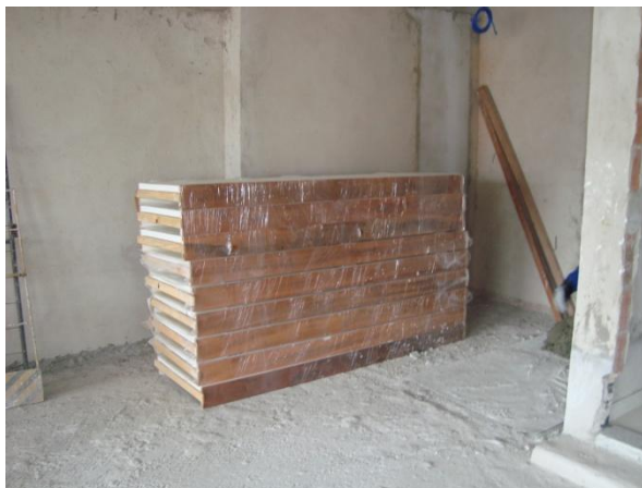
Figura 5.20 – Armazenamento das portas no pavimento Fonte: Autor
