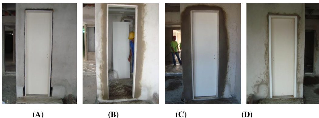
Figura 5.21 – A: Fixação permanente. B: Retirada da folha de porta. C: Acabamento. D: Fixação dos alisares Fonte: Autor
