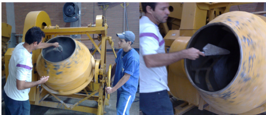
Figura 3.13 – Homogeneização dos materiais e a raspagem da betoneira pra evitar incrustações.
