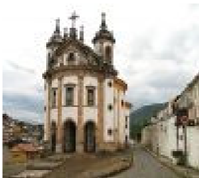
Figura 4 - Igreja de Nossa Senhora do Rosário Fonte: Site da Prefeitura de Ouro Preto, MG
