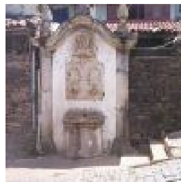
Figura 21 - Chafariz da Rua Barão de Ouro Branco
