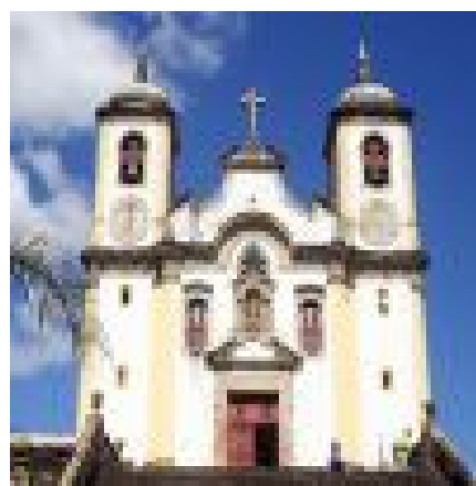
Figura 15 - Igreja de Santa Efigênia Fonte: Site da Prefeitura de Ouro Preto, MG
