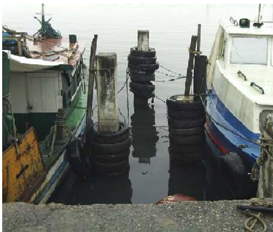
Foto XI – Desperdício de recursos, estacas mal colocadas e inutilizadas. Fonte: foto do autor, 2008.
