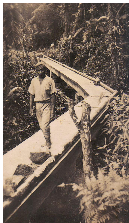
Trabalhador durante obras no continente 9
