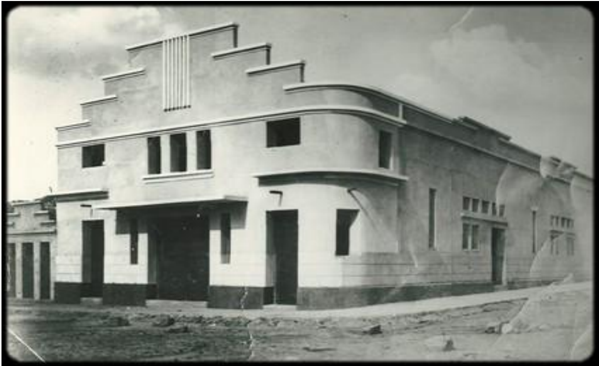
IMAGEM 20 - CINE TEATRO LUX AINDA EM CONSTRUÇÃO – 1953 (Fonte: Acervo de Verneck Abrantes de Sousa)
