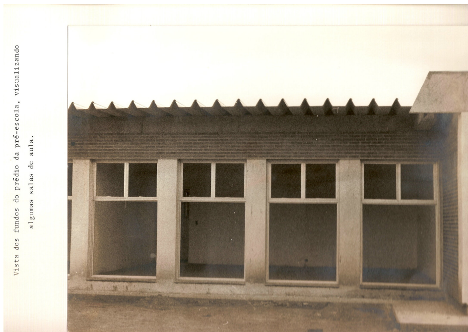
FOTO Nº. 10: Prédio Educação Infantil (algumas salas de aula).
