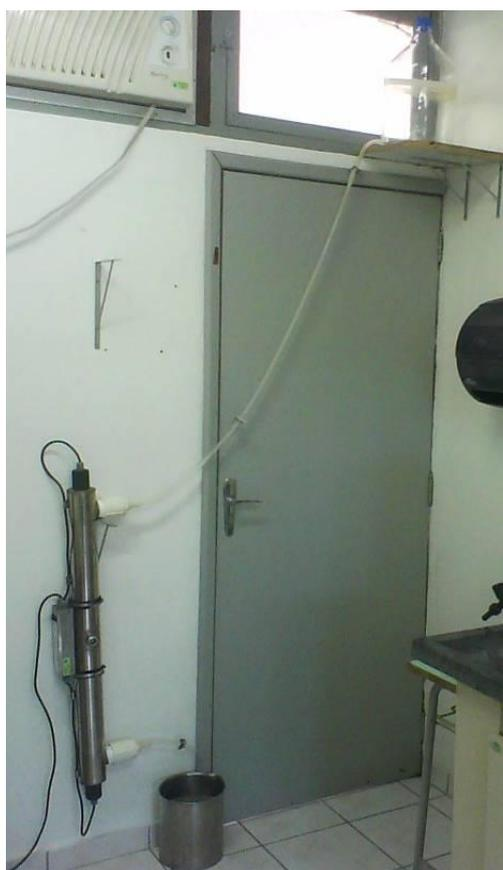
Figura 14 – Instalação do reator UV operado em processo de fluxo contínuo para o tratamento da água de chuva.
