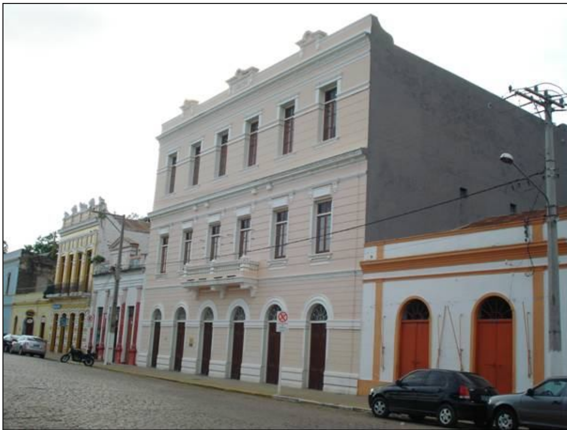
Figura 8. Edifício Wanderley, Baís & Cia. transformado em Museu da História do Pantanal, no Porto Geral de Corumbá-MS. Autora: FIGUEIREDO, N.P., 2010.
