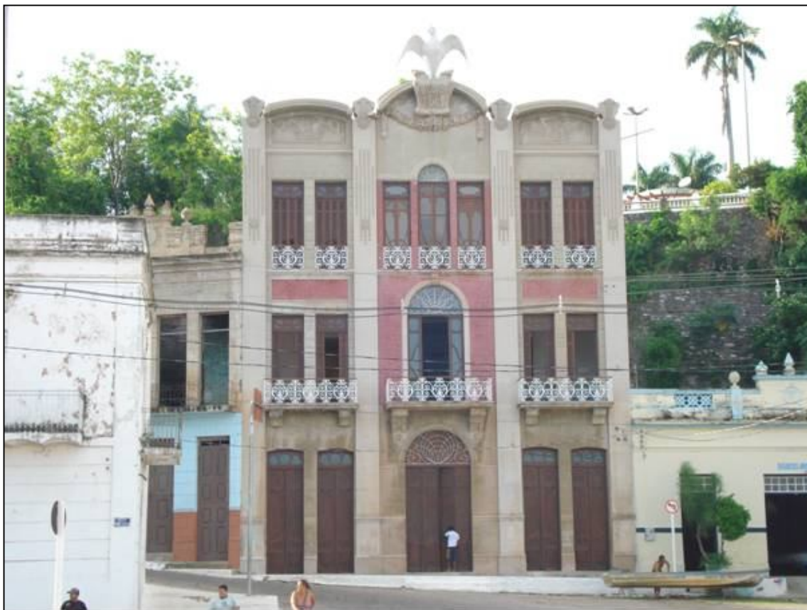
Figura 7. Casa Vasques & Filhos, em transformação para abrigar o Memorial do Homem Pantaneiro, no Porto Geral em Corumbá-MS.
