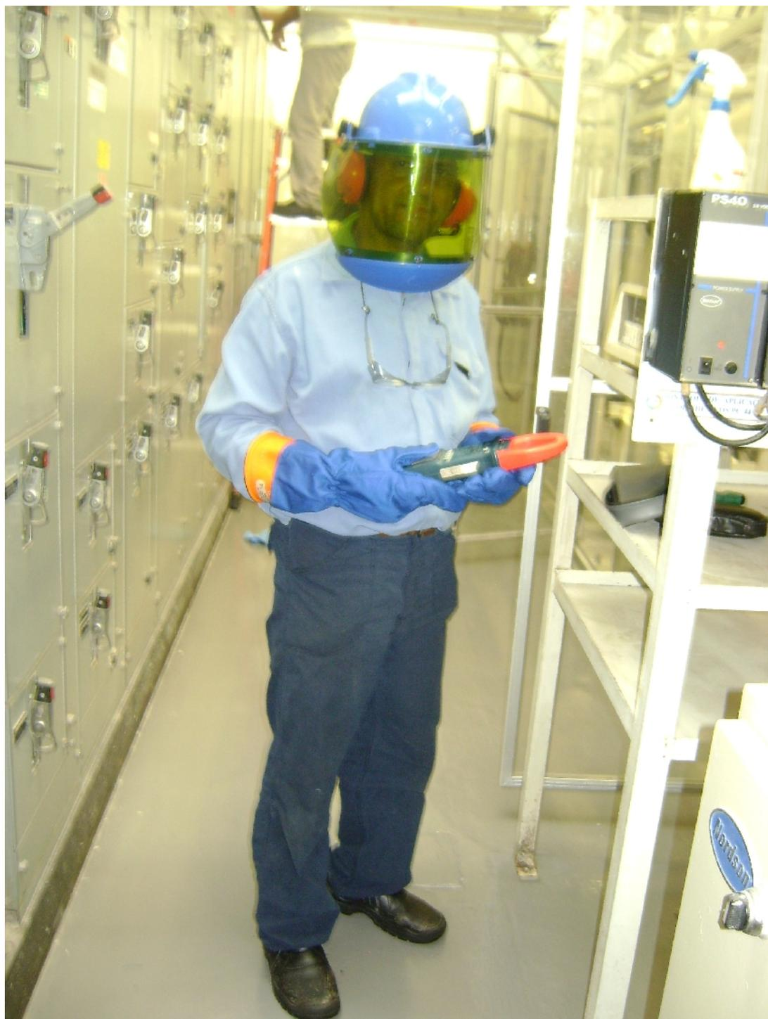
**Figura 10** – Instrumentista com equipamentos de segurança para levantamento de dados no campo
