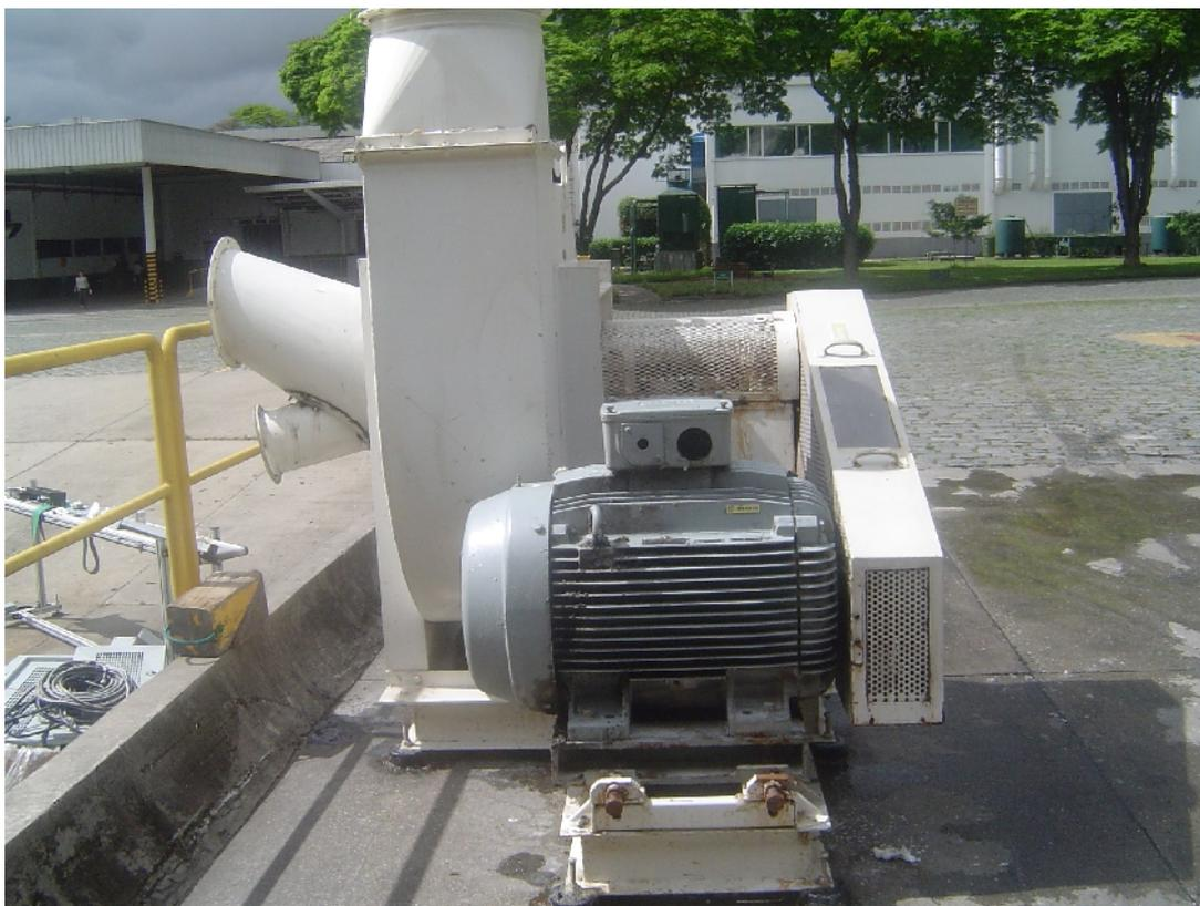
**Figura 11** – Ventilador antigo removido da unidade de produção
