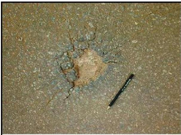
**Figura 2.43** – Características expansivas de um pavimento rodoviário construído com escória de aciaria LD – Ouro Branco – MG (GUMIERI, 2002).
